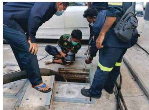
สูบลบตะกอนระบบบำบัดน้ำเสีย (12/02/66)
