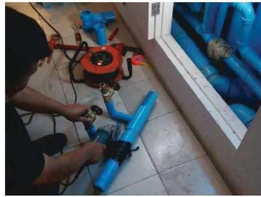
เจ้าหน้าที่ซ่อมแซมระบบเส้นท่อประปา
