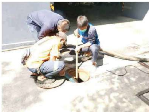
สูบลบตะกอนระบบบำบัดน้ำเสีย (12/02/66)
